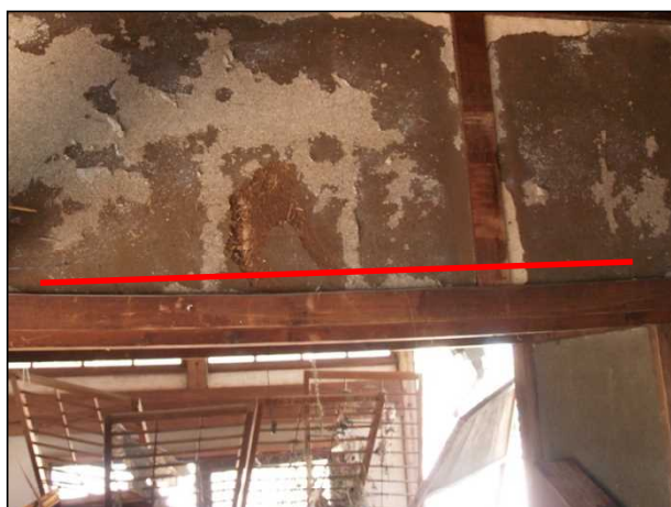
柱、梁が若干たわんでいる。
