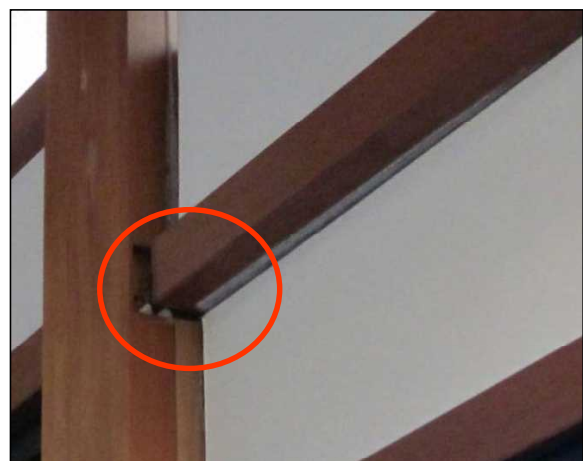
柱と梁の仕口にずれが生じている。
