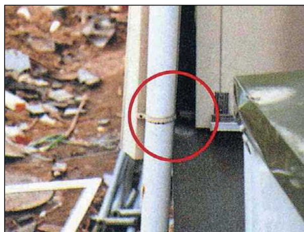
アンカーボルトの伸びが見られる。
