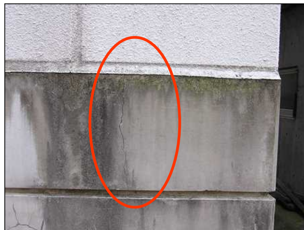
柱脚コンクリートのひび割れが見られる。
