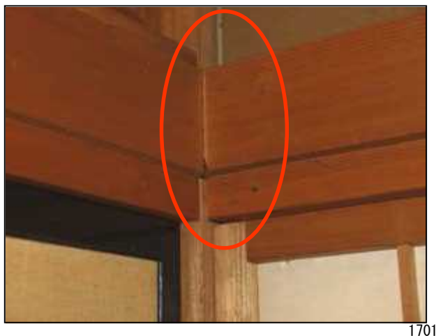
柱と梁の仕口にわずかなずれが生じている。
