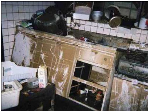
(台所の流し台：転倒し、配管が切れている。)
