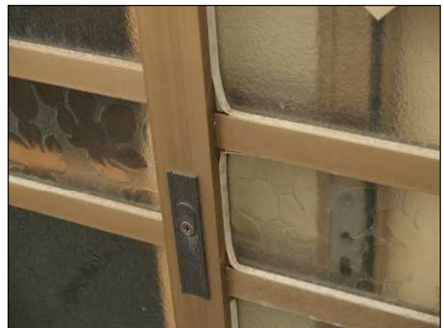
【アルミサッシ】 鍵の破損や、ビード(ガラスを固定するゴムパッキン)のはずれが見られる。
