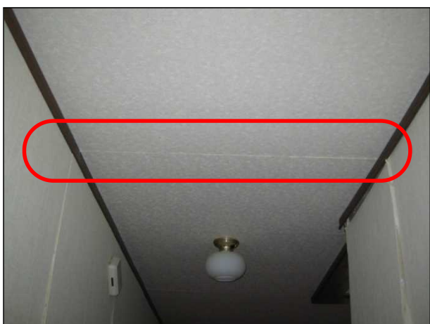
天井板に隙間が生じている。
