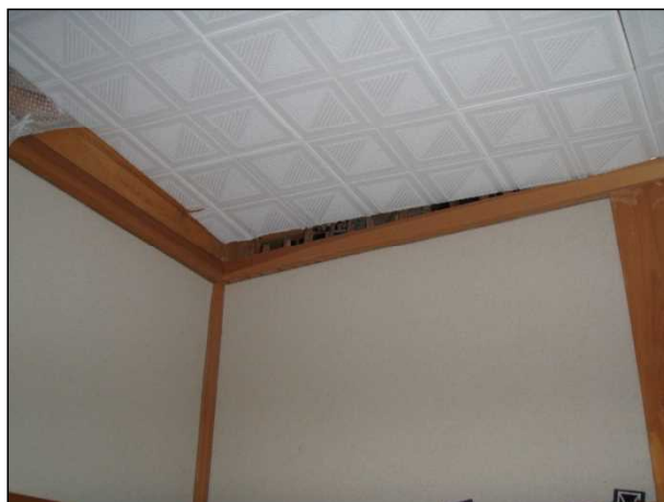
天井板の浮きが生じている。
