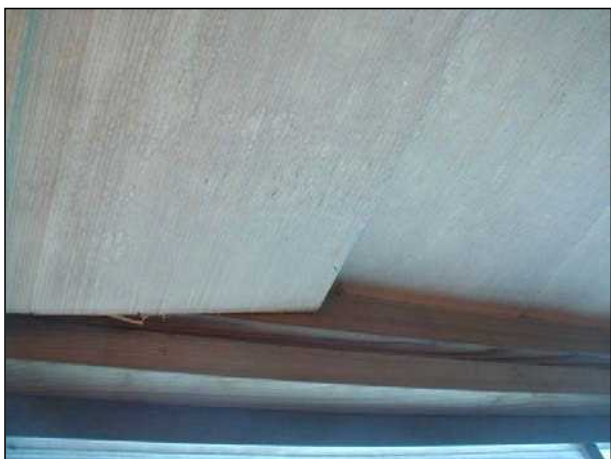
天井板の浮きが生じている。
